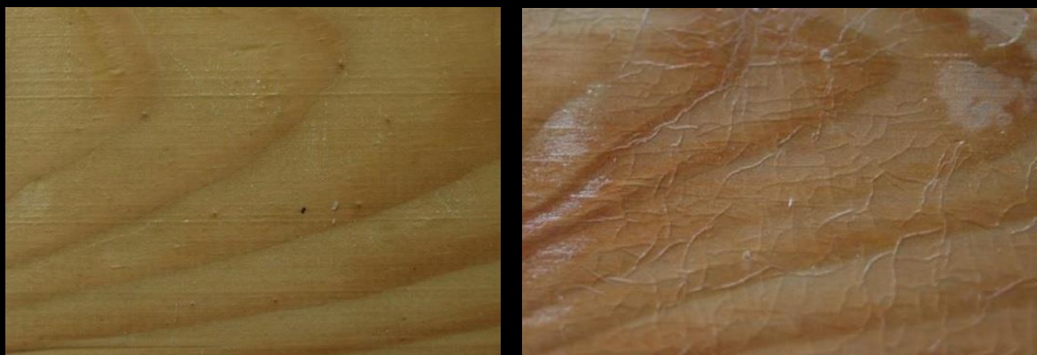
Zdj.1. Powierzchnia drewna zabezpieczona w sposób: a) prawidłowy, b) nieprawidłowy.
